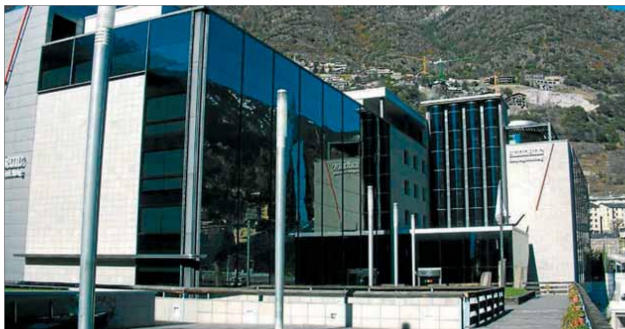
Edifici que acull la seu central d'Andbanc al municipi andorrà de les Escaldes i Engordany ■ AVUI
